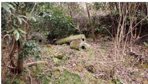
石造樋管 遺構
