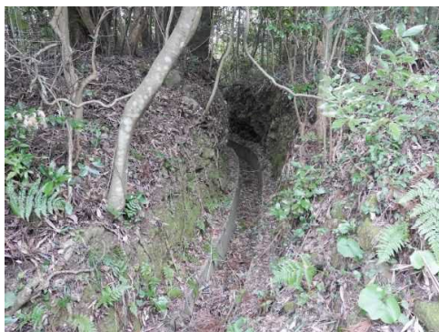
古池から美迫池への掘り掛け水路
