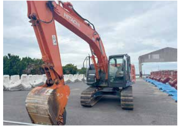
工事などで使うショベルカーを川に入れる
