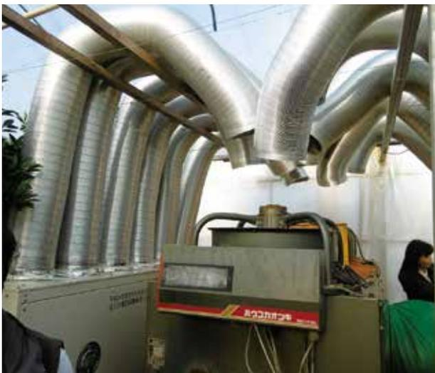
上部はヒートポンプからの排気口、下部はA重油を焚いて加温するボイラー。ボイラーの上には送風機があり、ビニールハウス内に温風が送られるような仕組みになっている。
